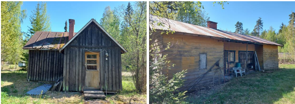
Kuva 9. Vasemmallä pihapiirin päärakennus ja oikealla talousrakennus keväällä 2024. Rakennukset on purettu marraskuussa 2024.
