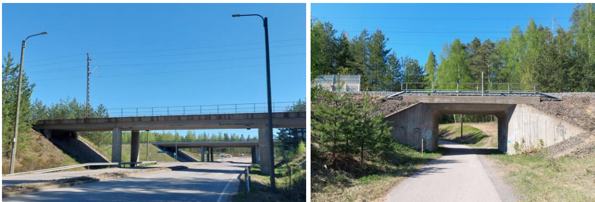
Kuva 10. Vasemmalla Hongiston alikulkusilta pohjoisen suunnasta kuvattuna. Sillan takana näkyy valtatie 6:n alikulkusilta. Oikealla Pulpin alikäytävä etelän suunnasta kuvattuna.
